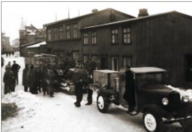
Lagt af stað með rafal Fossavatnssstöðvar.
